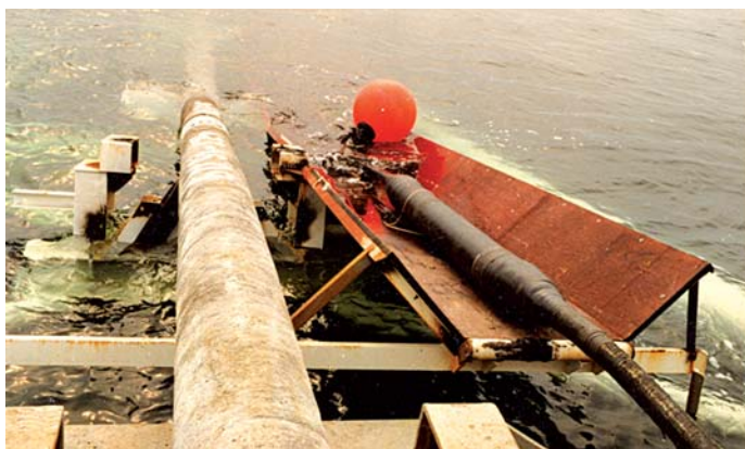
Hier senkt ein Verlegeschiff die fertig geschweißten und isolierten Rohrstränge in den vorbereiteten Gräben am Meeresgrund. (Fotos: vdbum)
