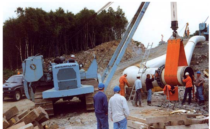
Hier wird ein Formstück mit Hilfe eines Seitenbaumes vorgehalten. Die schweren Hebegurte werden auch eingesetzt, um die vorhandene Isolierung nicht zu beschädigen.
