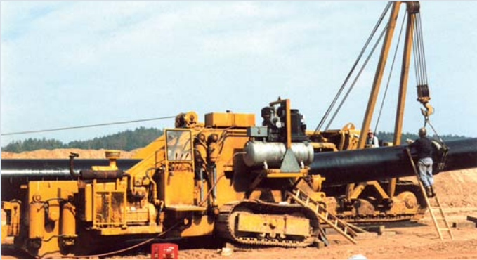
Bei dieser Rohrbiegemaschine ist gut zu erkennen, dass sie das schon isolierte Rohr sehr präzise in den gewünschten Winkel bringt, ohne die Außenisolierung zu beschädigen.
