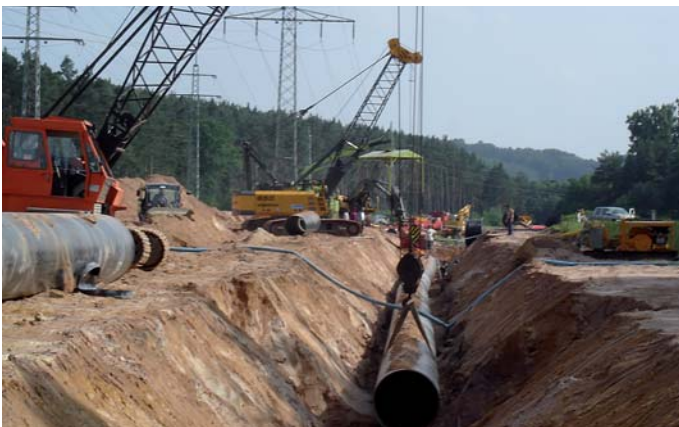
Seilbaggerfahrer müssen sehr präzise und abgestimmt arbeiten, um den fertig geschweißten Rohrstrang in den vorbereiteten Graben abzusenken. (Fotos: vdbum)
