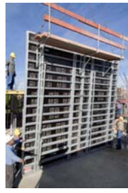
Ein Beispiel aus der Praxis: Aufstellen des Schalelementes mit einem Kran.
